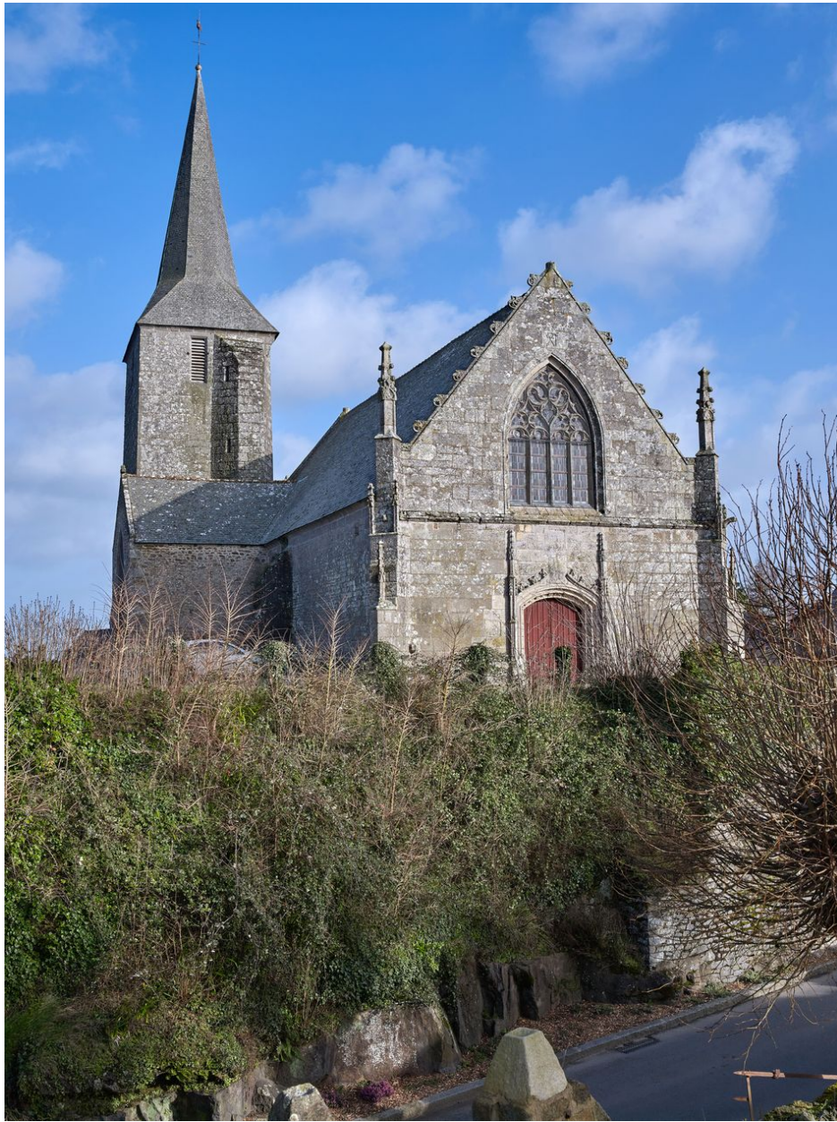
Vue de situation : élévation ouest de l'église, affleurement rocheux
