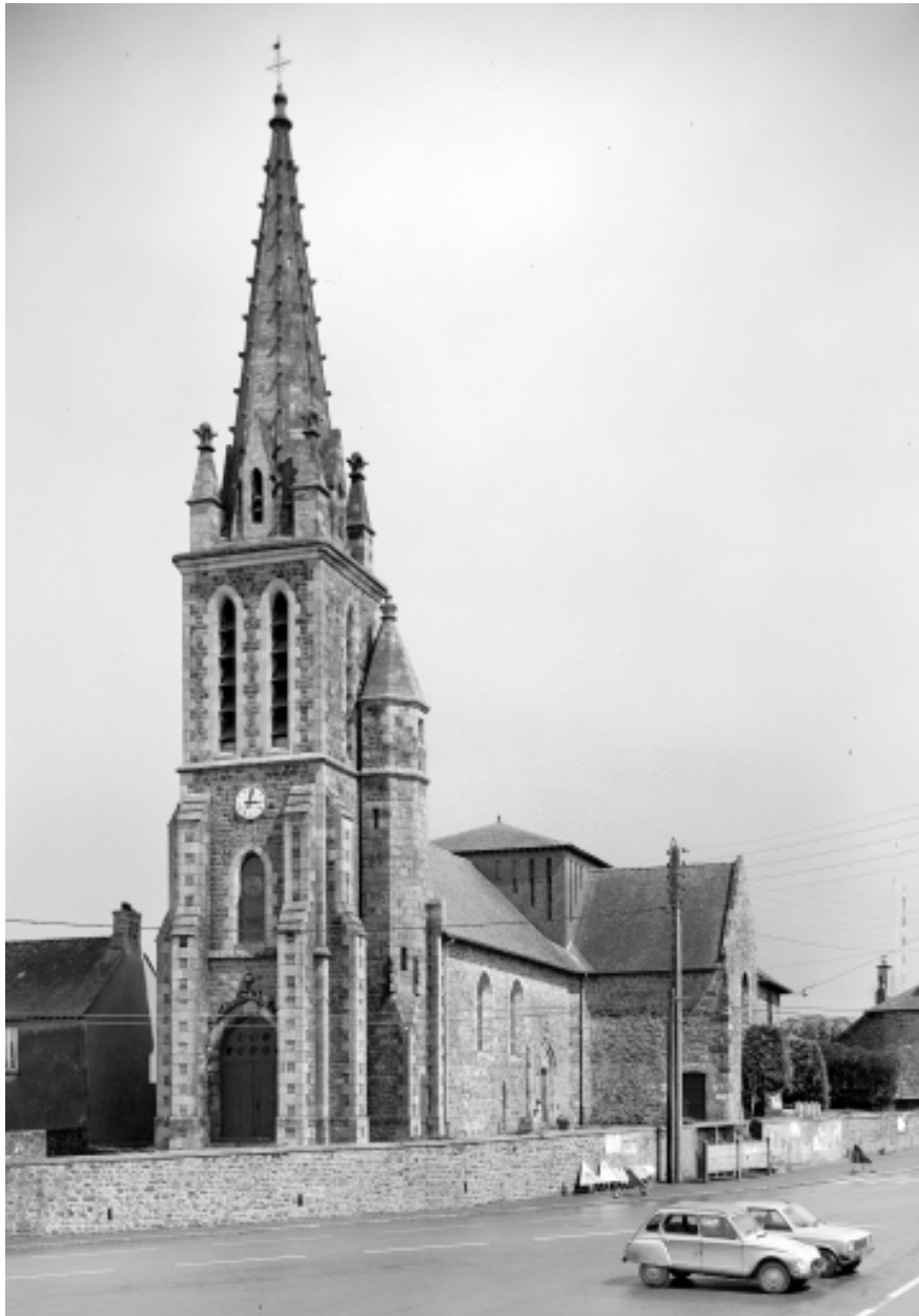
Elévation sud-ouest : vue générale
