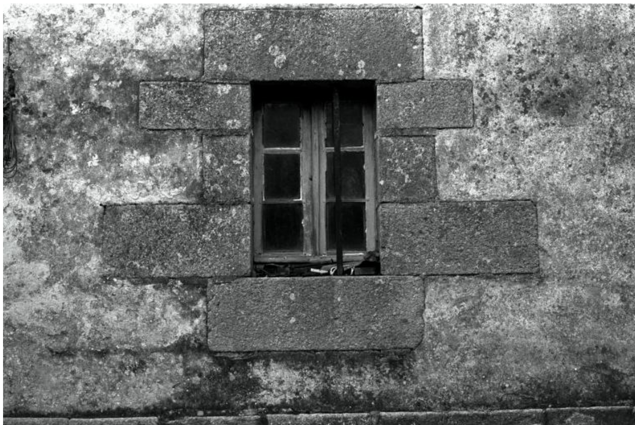
Logis, rez-de-chaussée, détail d'une fenêtre. (1977)
