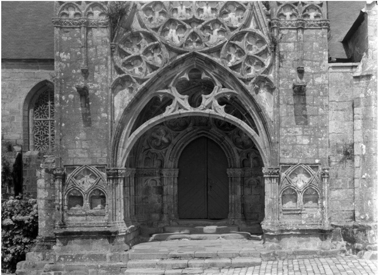
Porche sud, partie inférieure
