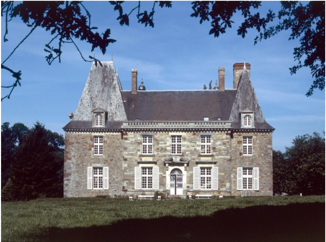
Façade ouest, vue générale.
