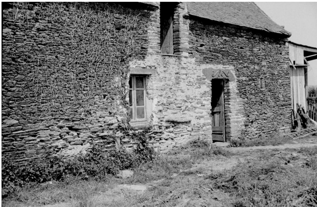
Rohan, ferme datée 1625, transformée au 19e siècle (état en 1969)
