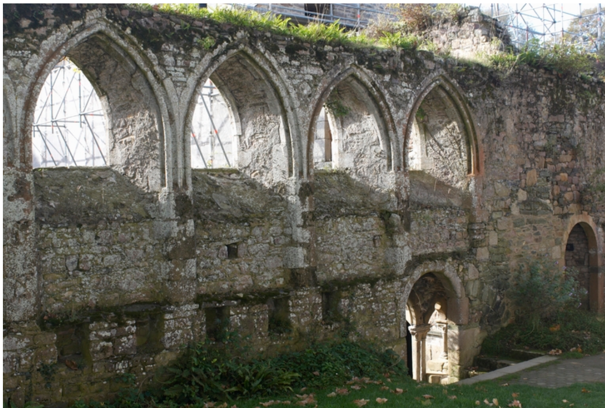
Mur sud de la salle du réfectoire
