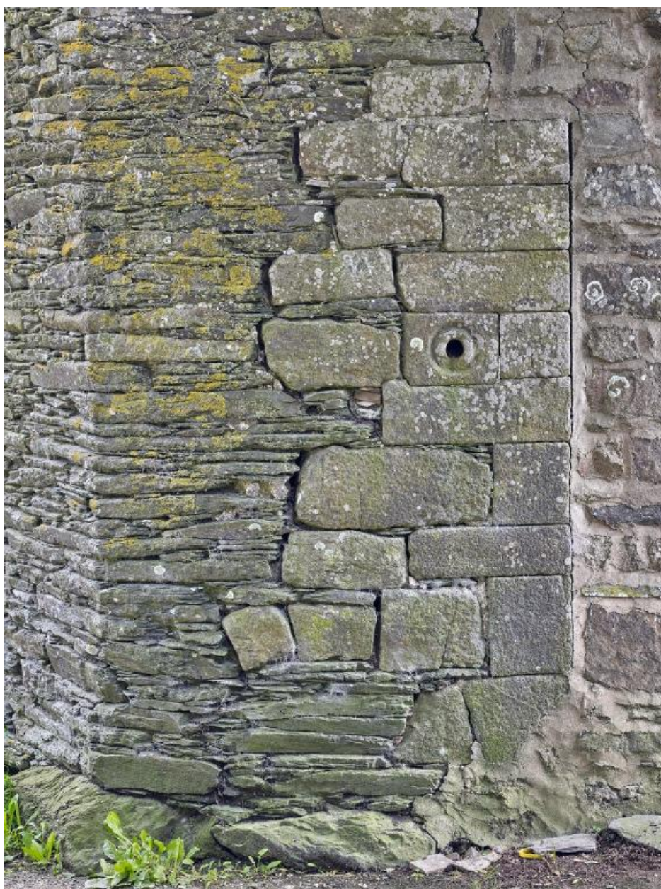
Portail d'entrée flanqué d'une petite ouverture de tir
