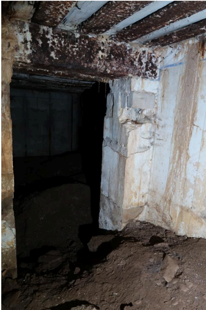
Vue de l'entrée de la pièce de vie - chambre de troupe depuis le couloir d'entrée (état en 2021)
