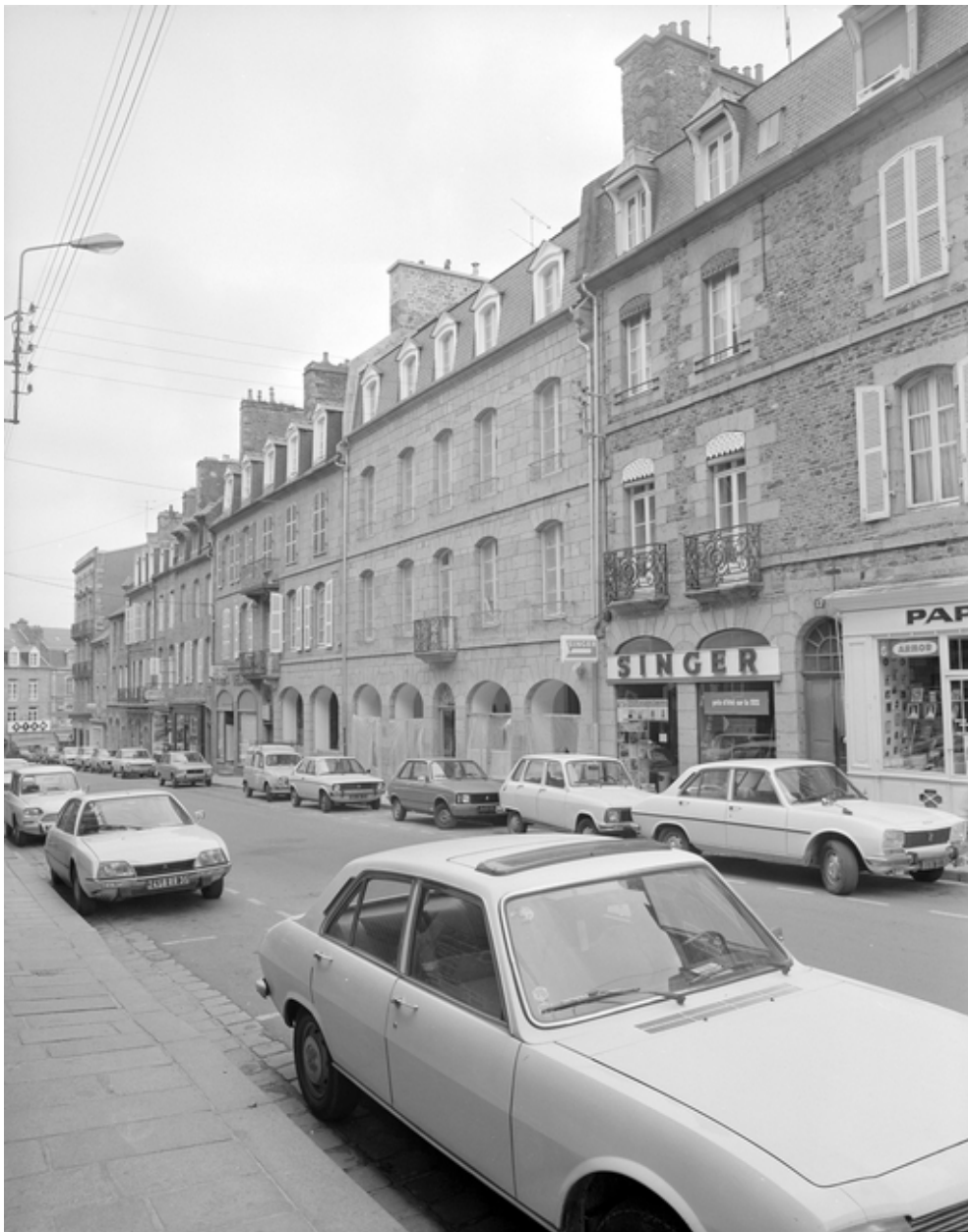
15 rue Nationale, élévation antérieure, vue générale.
