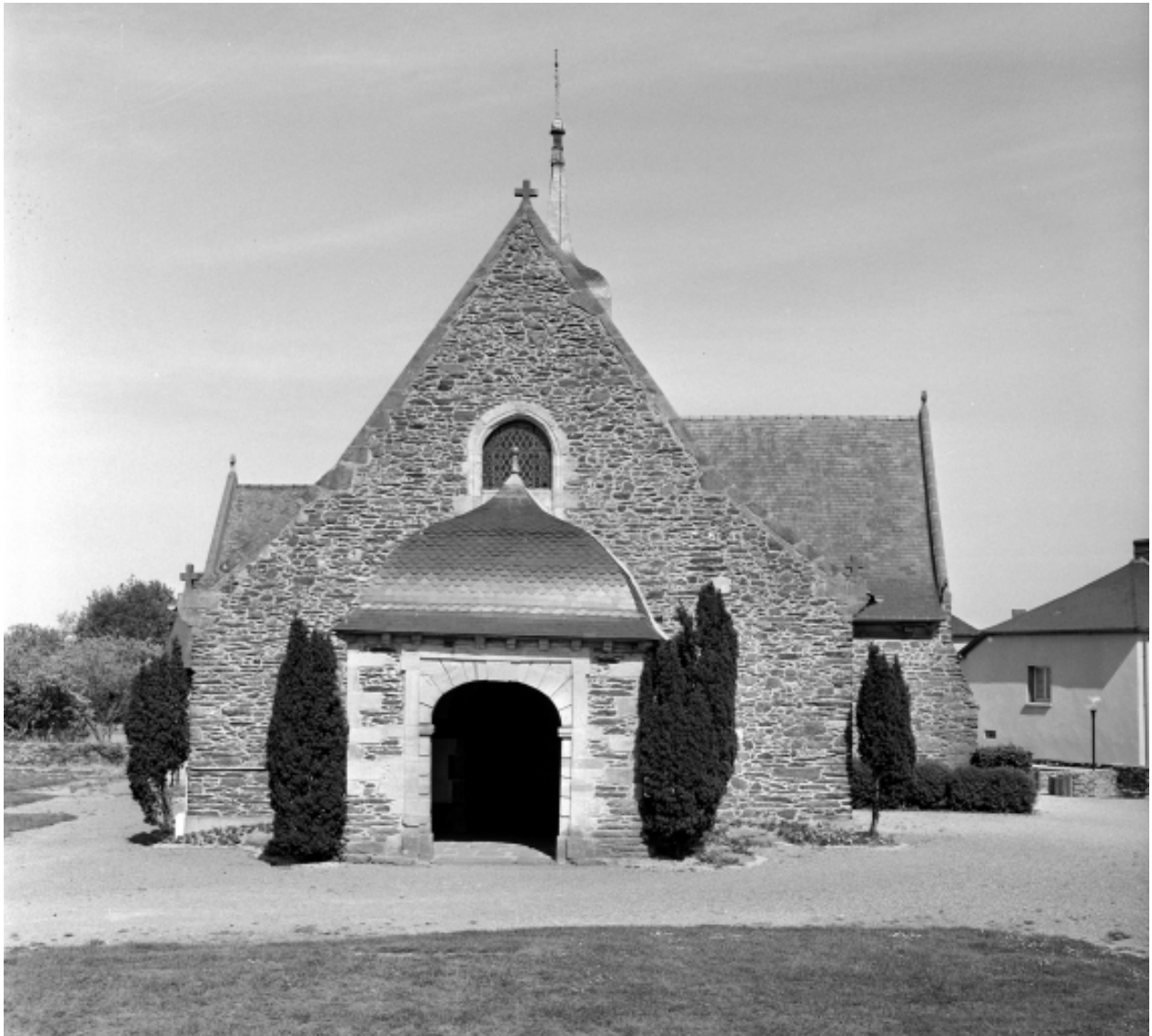
Elévation Ouest : vue générale (état en 1994)
