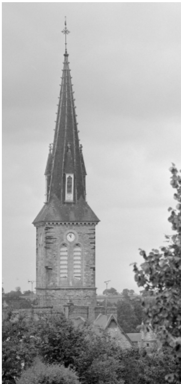
Clocher : vue générale (état en 1994)
