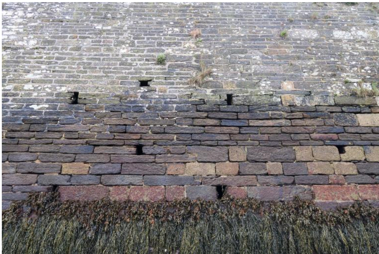
Mur de soutènement, détail de maçonnerie et barbicanes
