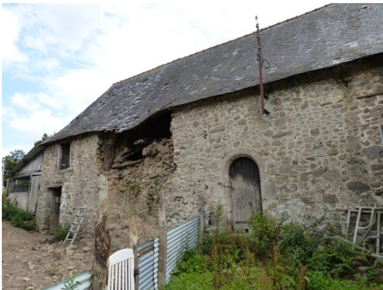
Vue générale, Bêlême (Hédé-Bazouges)
