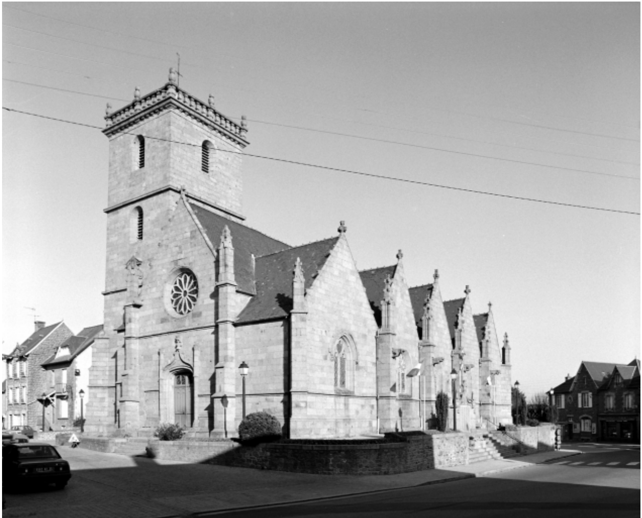
Elévation Sud-Ouest : vue générale
