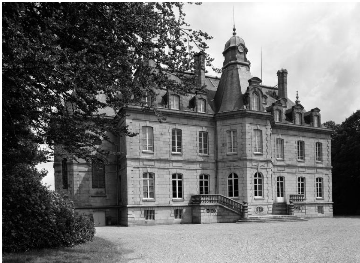
Logis, élévation est, vue générale de trois quarts
