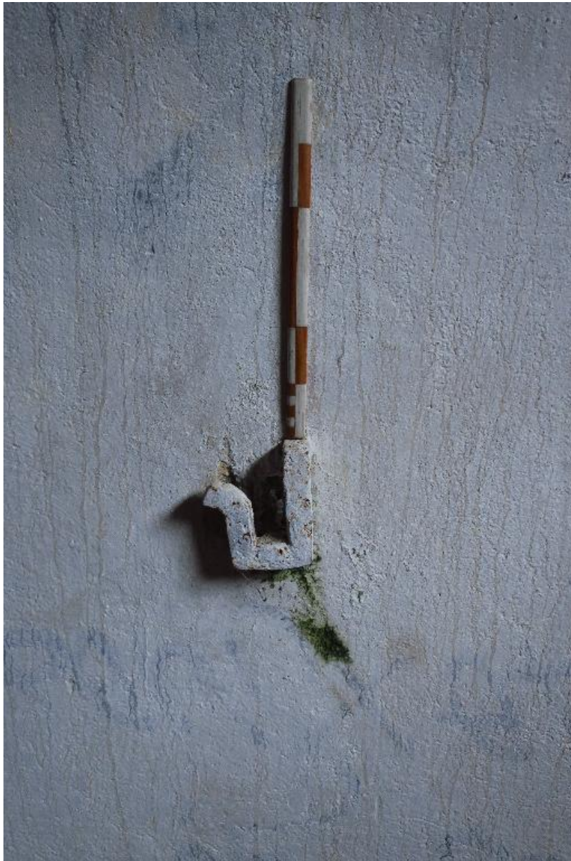
Archipel de Glénan, batterie de Penfret, corps de garde crénelé, détail d'un support de barre d'accrochage de hamacs.
