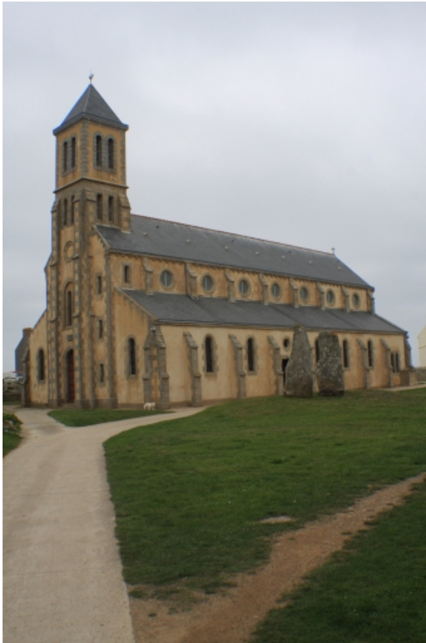
Ile-de-Sein, église paroissiale Saint-Guérolé : vue générale sud-ouest
