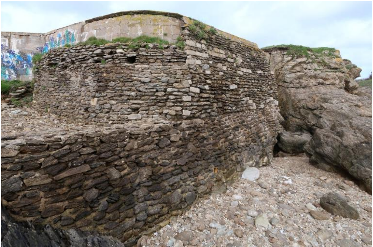
Vue depuis le sud-sud-est. La maçonnerie de moellon masque le bunker - abri
