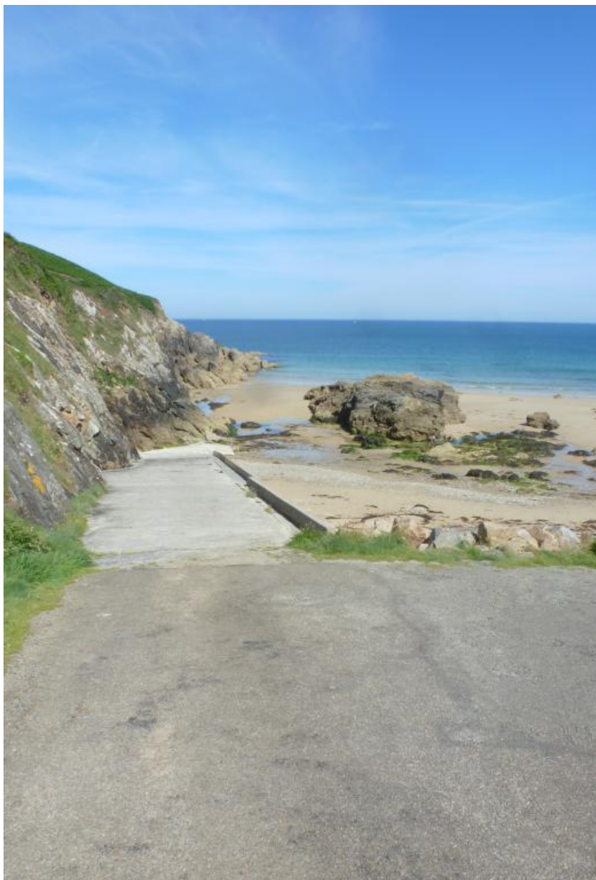
Cale, vue prise du sud.
