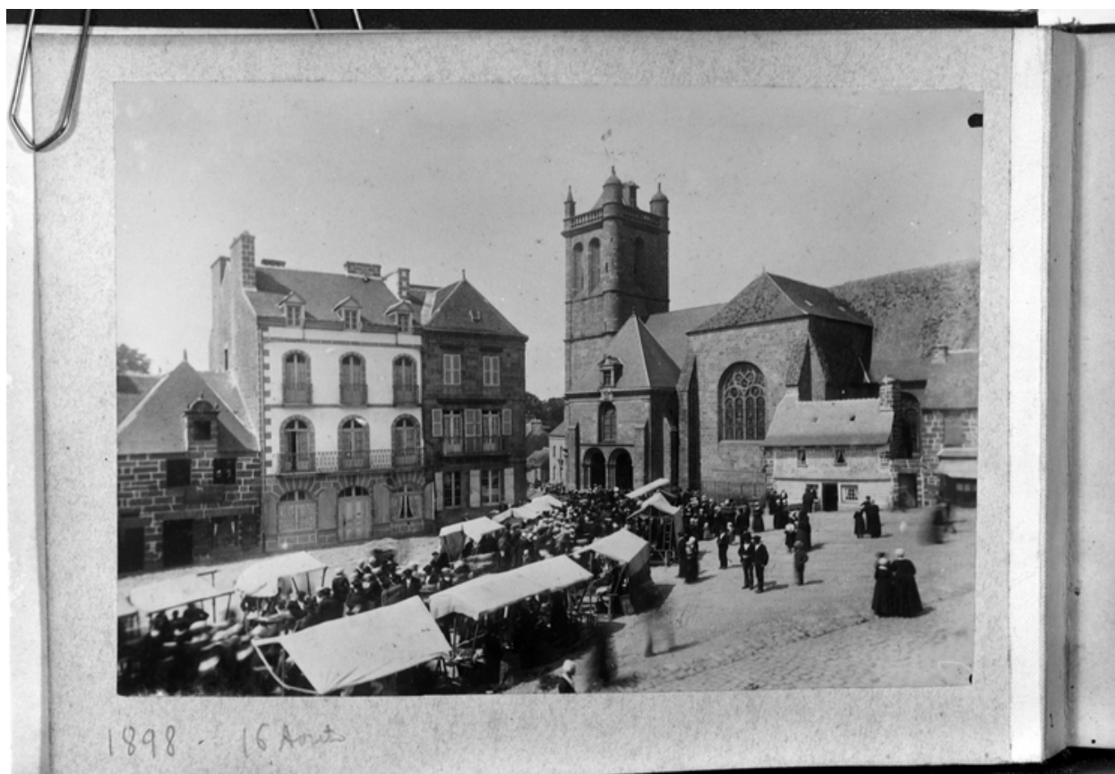
Vue générale de l'angle nord est de la place et de la façade sud de l'église (album du Dr Bouché, 1898)
