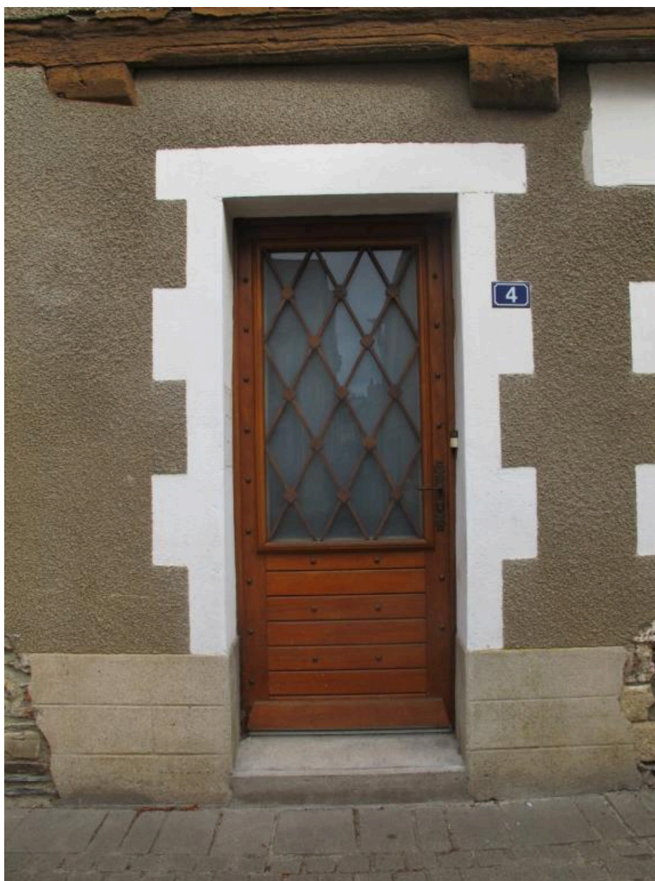
Façade nord. Rez-de-chaussée, partie ouest, porte
