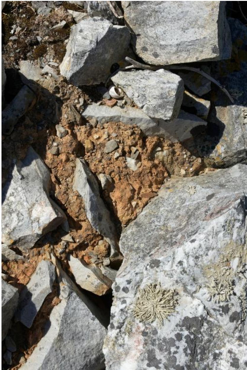
Camaret, pointe du Toulinguet : batterie de côte, détail du mortier
