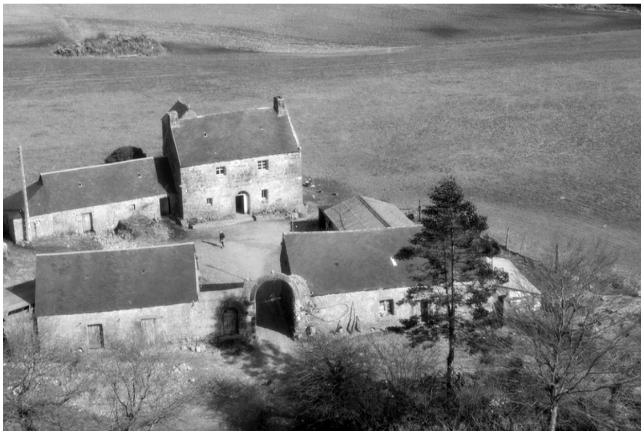
Vue aérienne prise du sud
