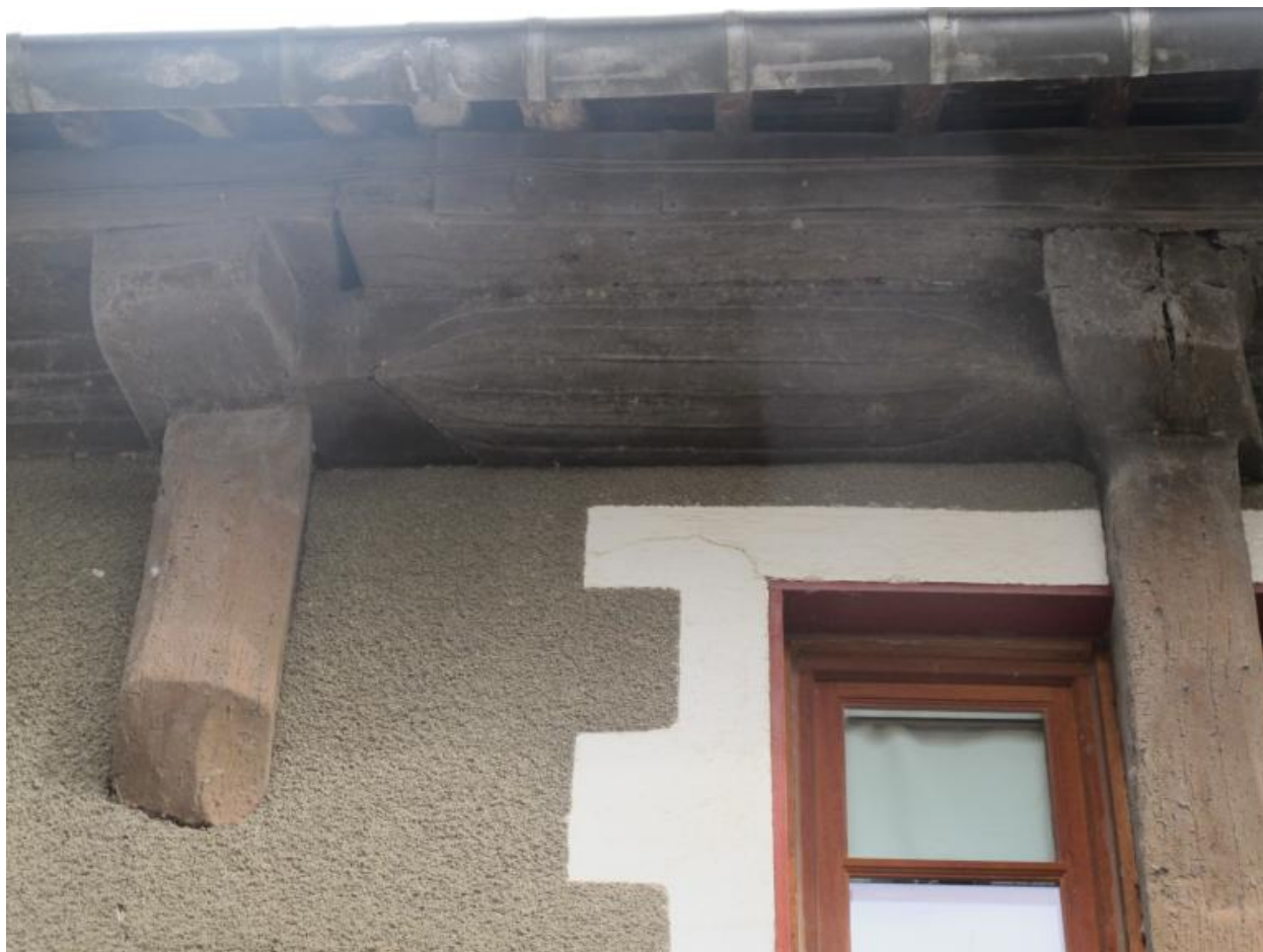
Façade nord. Premier étage, partie ouest, détail de l'entretoise moulurée
