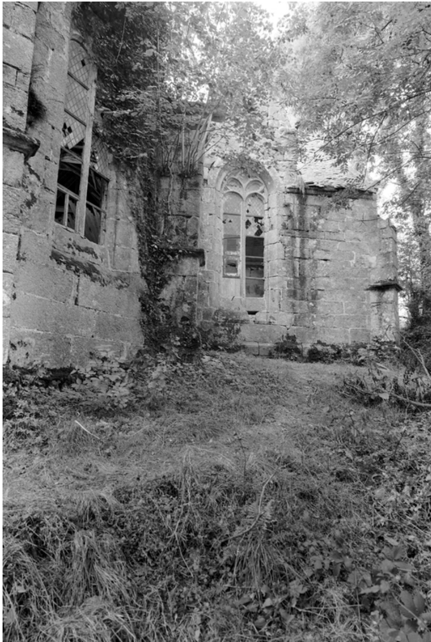
Face nord du chevet et mur est du bras nord
