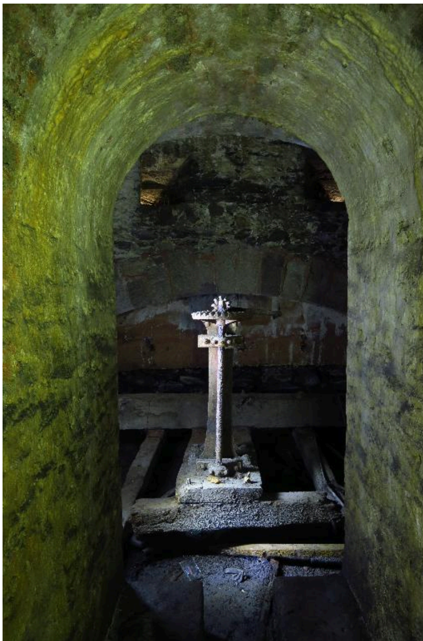
Le Palais, enceinte urbaine, porte de Bangor, chambre de manoeuvre du pont coulissant.
