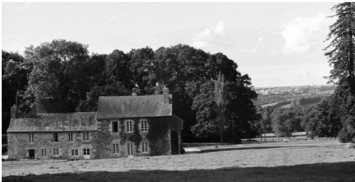
Manoir, façade sud, vue générale
