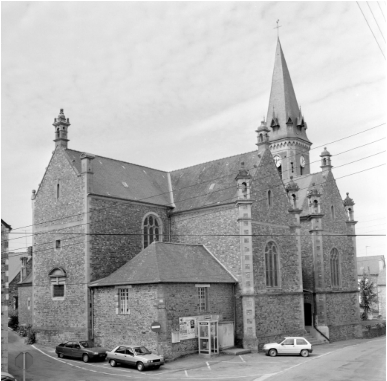
Elévation Nord-Est : vue générale
