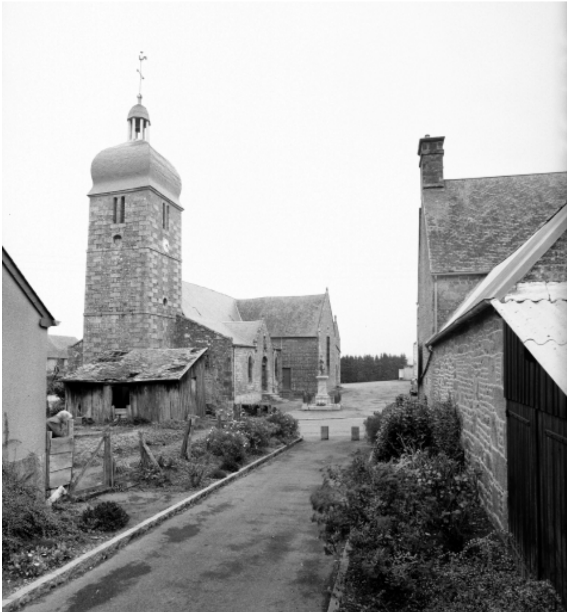
Elévation Sud-Ouest : vue de situation
