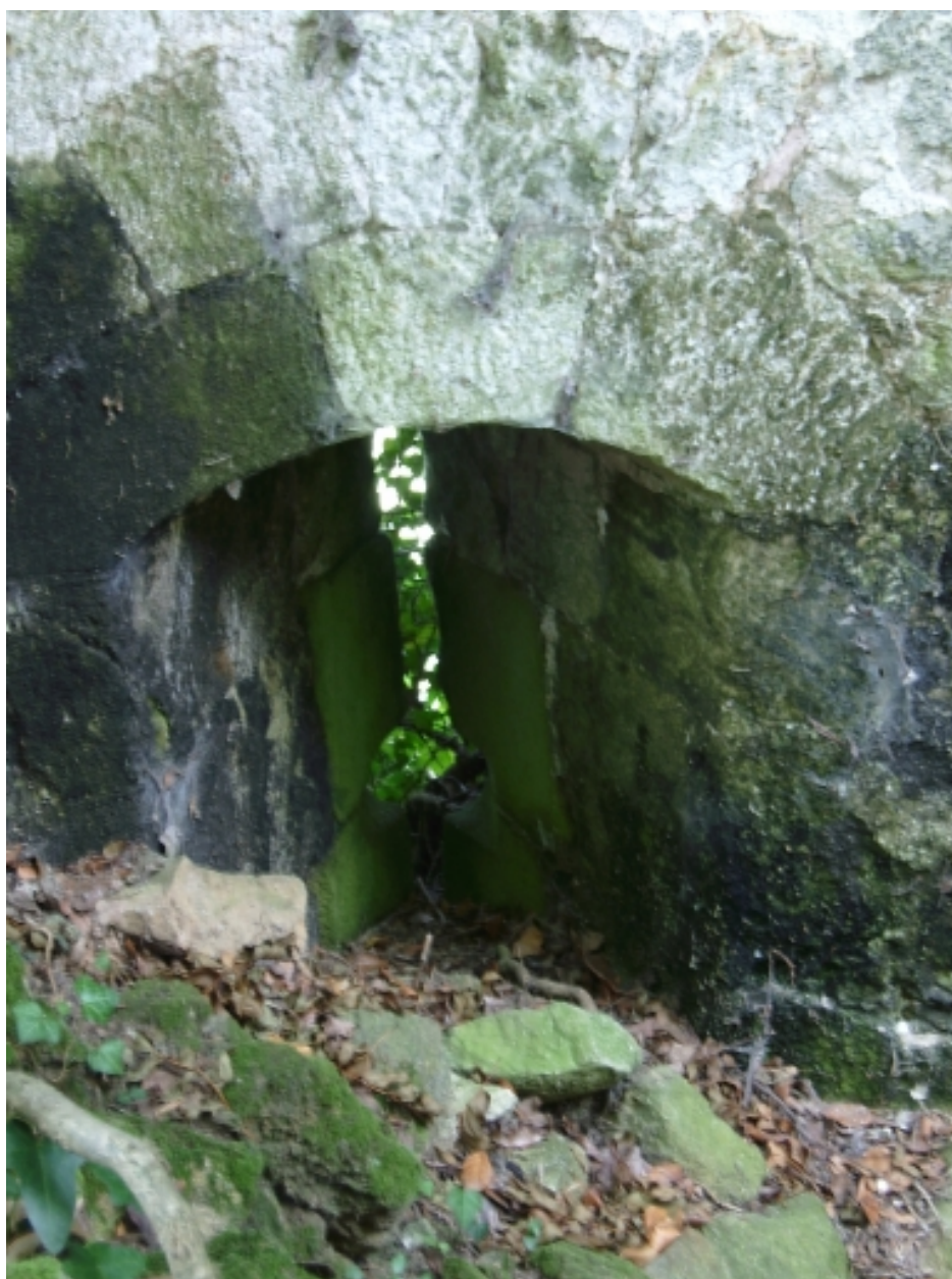
Château de la Touche-à-la-Vache, vue intérieure du donjon, bouche-à-feu
