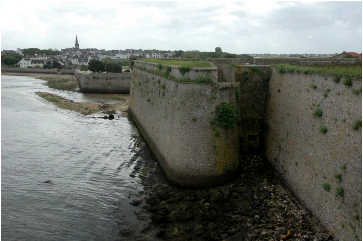
Vue de la citadelle de Port-Louis : embrasures rasantes de l'orillon nord du bastion Dumourier
