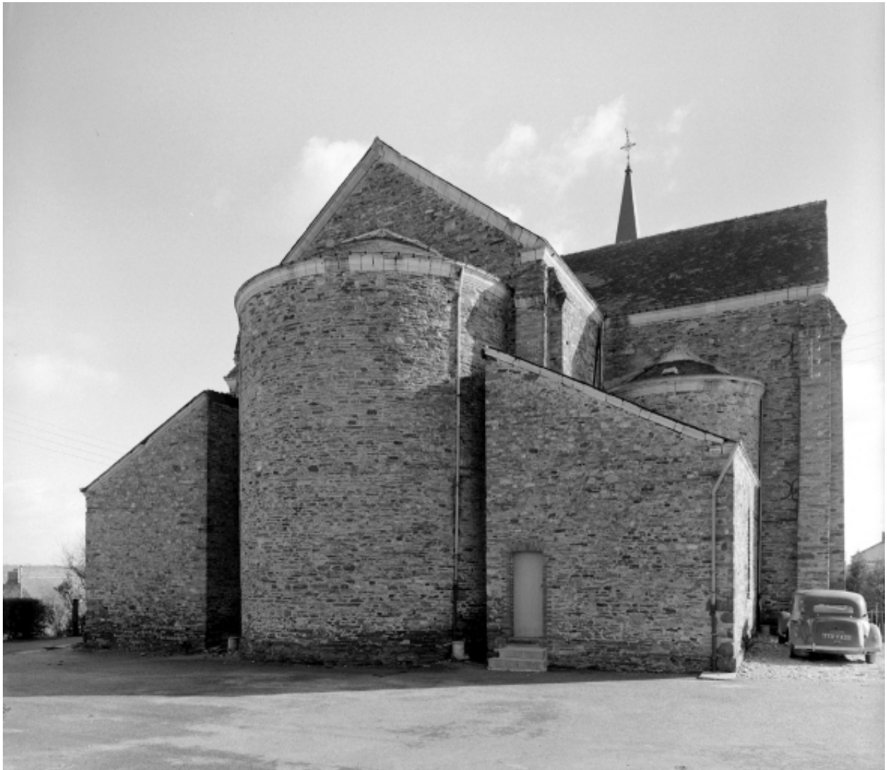
Elévation Est : vue générale
