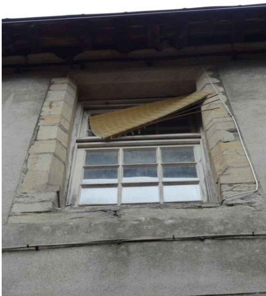
Fenêtre du premier étage de la façade ouest
