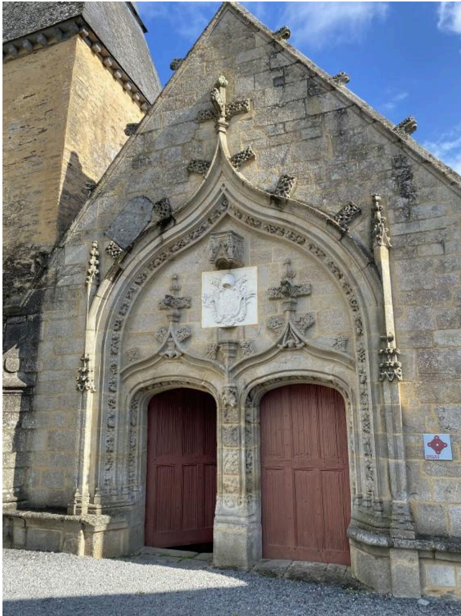
Élévation ouest : le portail
