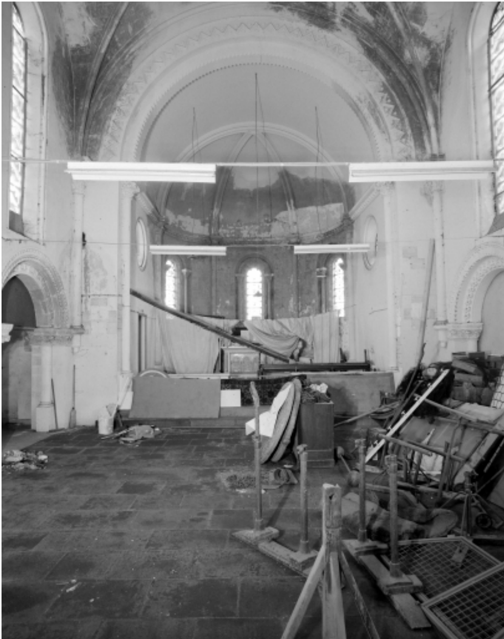
Intérieur : vue générale vers le chœur
