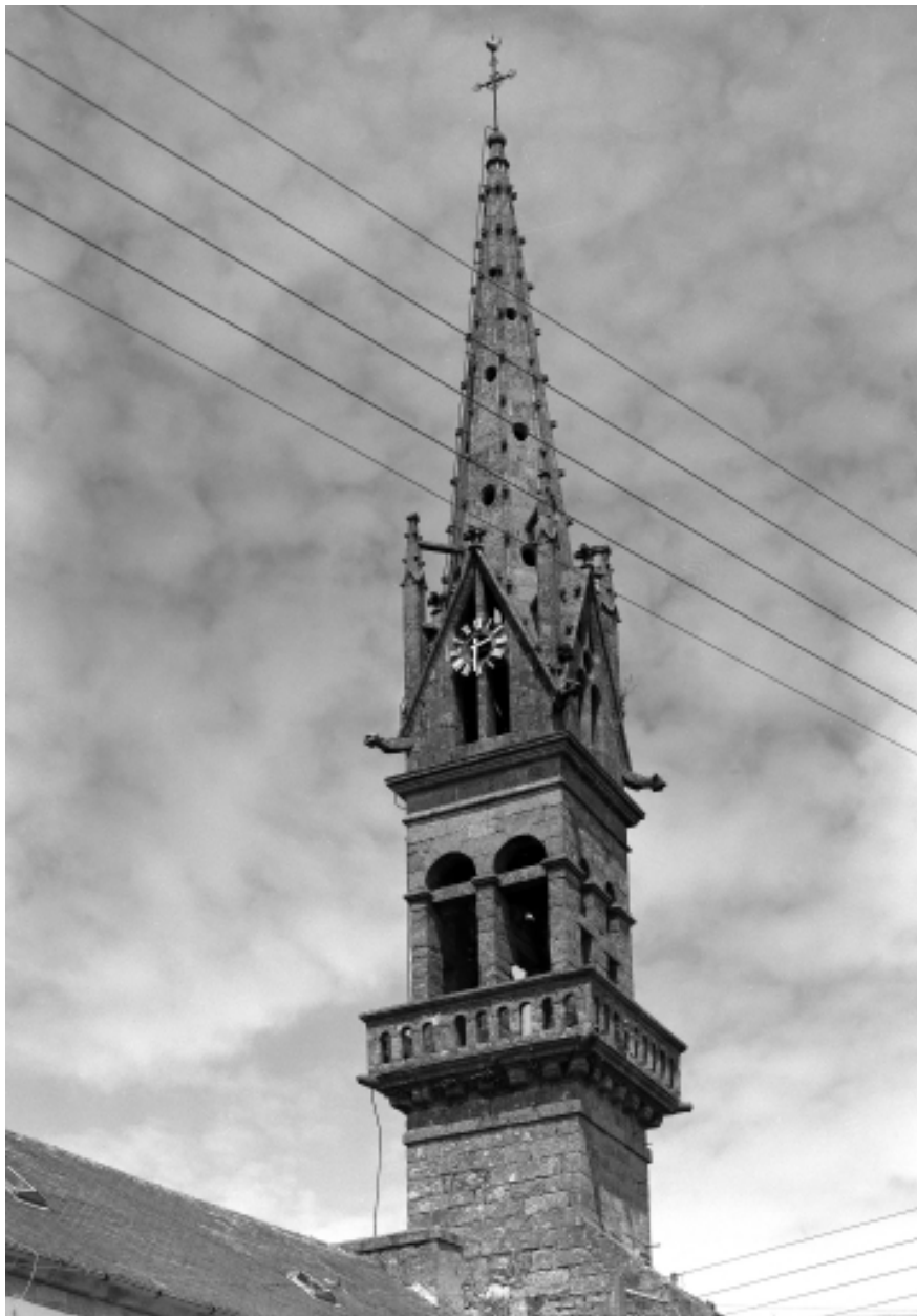
Plomodiern, église paroissiale Saint-Mahouarn : façade occidentale, détail clocher, état en 1972
