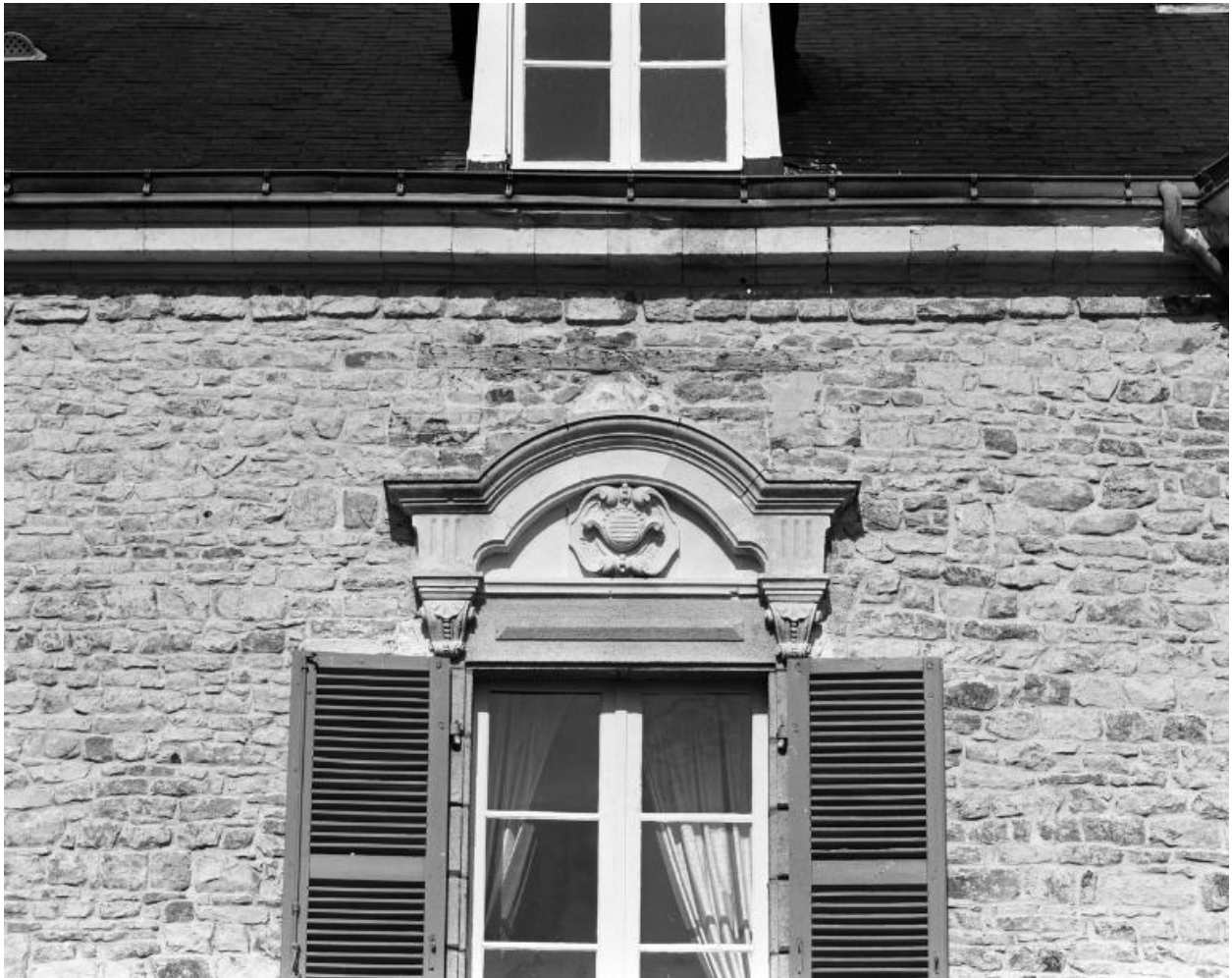
Elévation est, fenêtre : deuxième travée sud.
