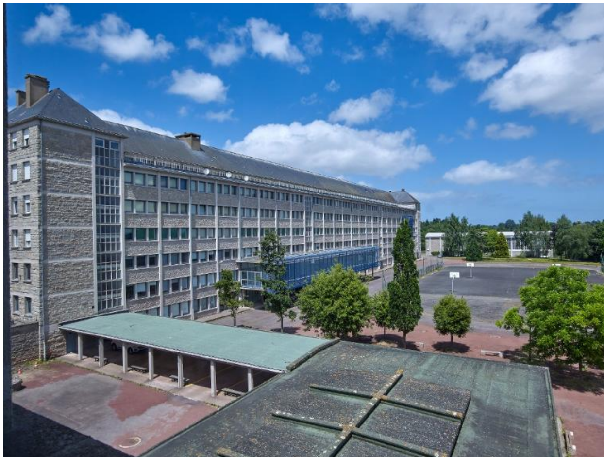
Vue d'ensemble, prise du sud-est, de l'internat garçons - externat.
