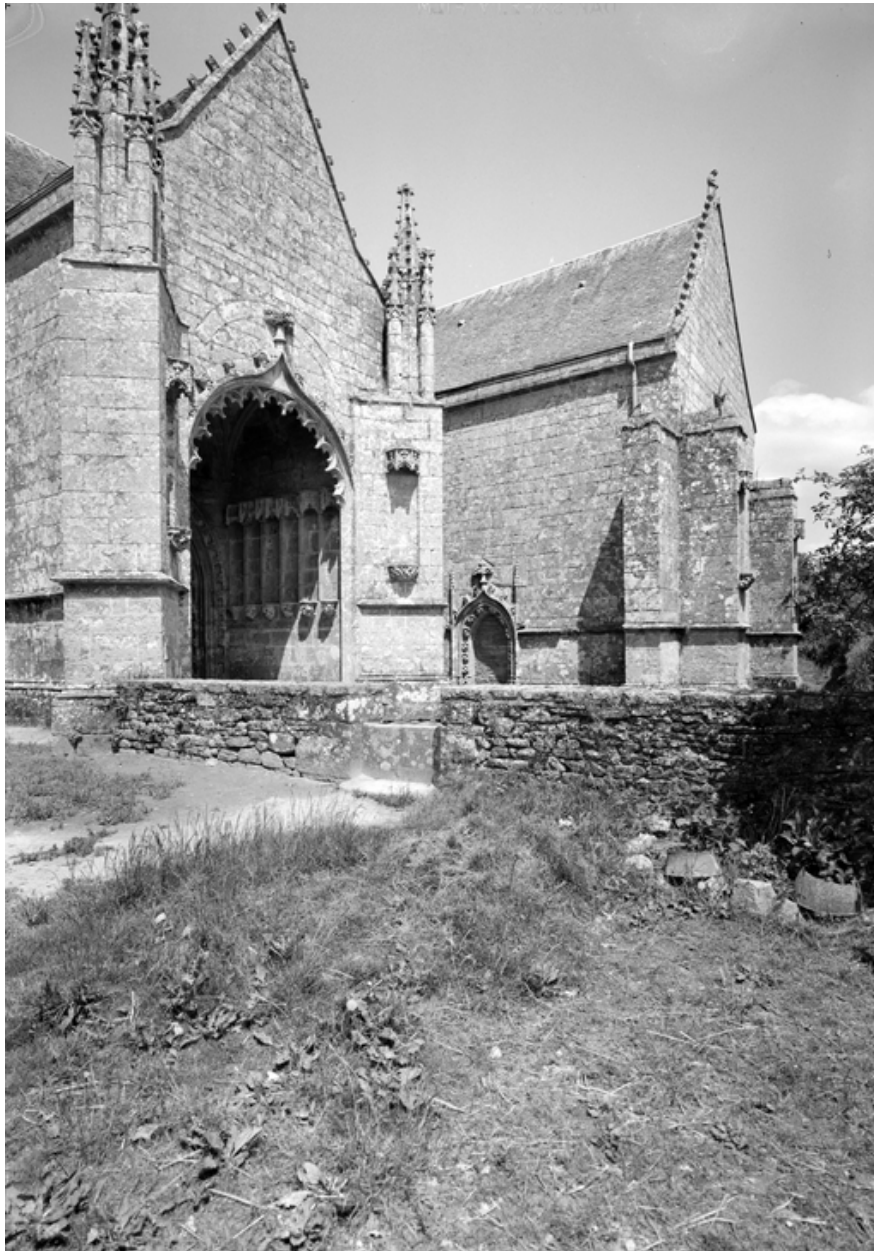
Façade sud, le porche et le croisillon pris du sud-ouest.
