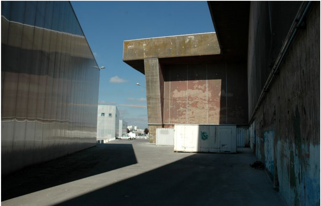
Vue de l'élévation ouest située derrière les docks : contrefort et dalle de couverture (2005)
