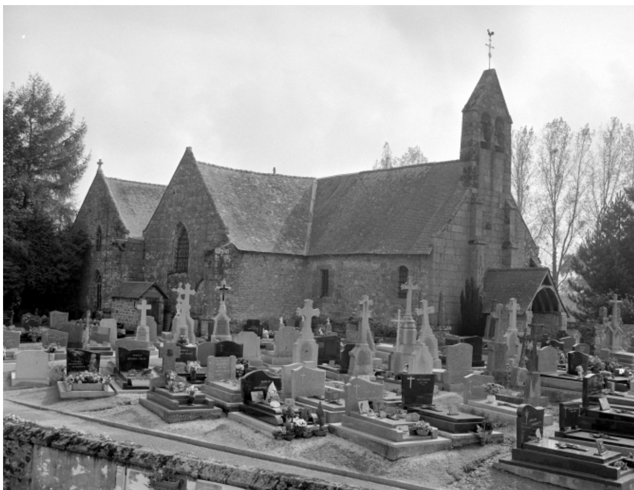
Elévation Nord-Ouest : vue générale
