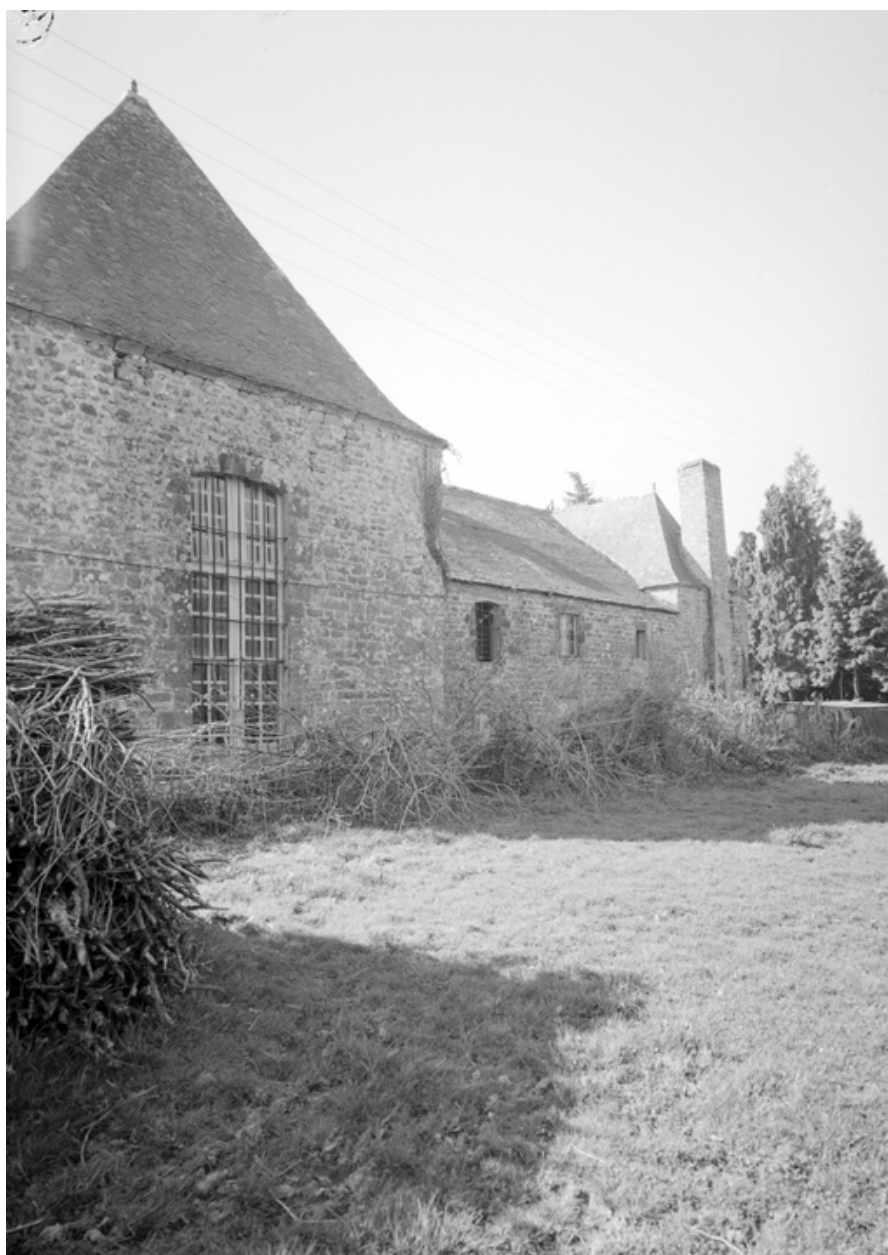
Façade postérieure du pavillon nord-ouest prise de l'angle du pavillon d'escalier
