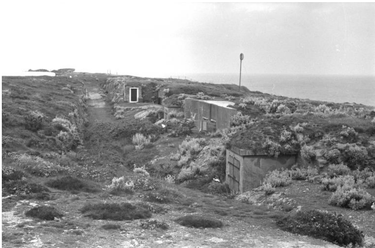
Batterie, vue générale
