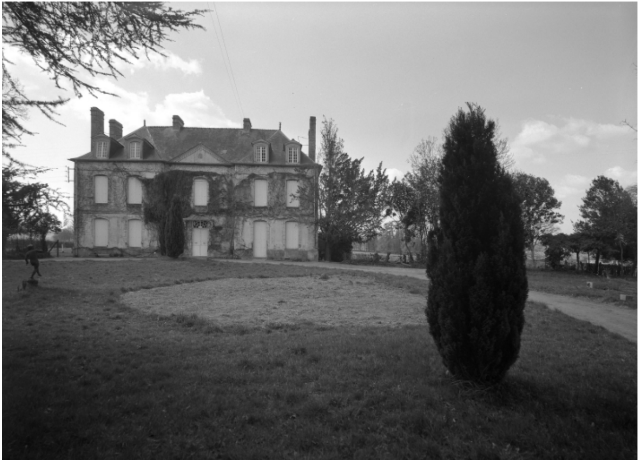
Façade nord-est, vue générale.
