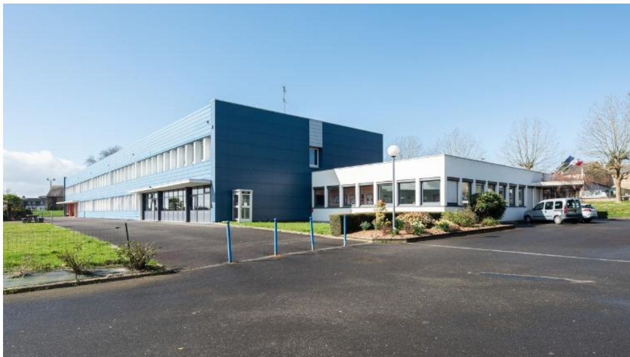
Bâtiment E, externat et administration : vue d'ensemble prise de l'est. Albert Hec et Roger Besnard, architectes, 1969.
