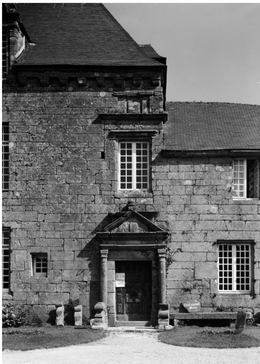
Porte et fenêtre de la travée centrale sur la façade sud
