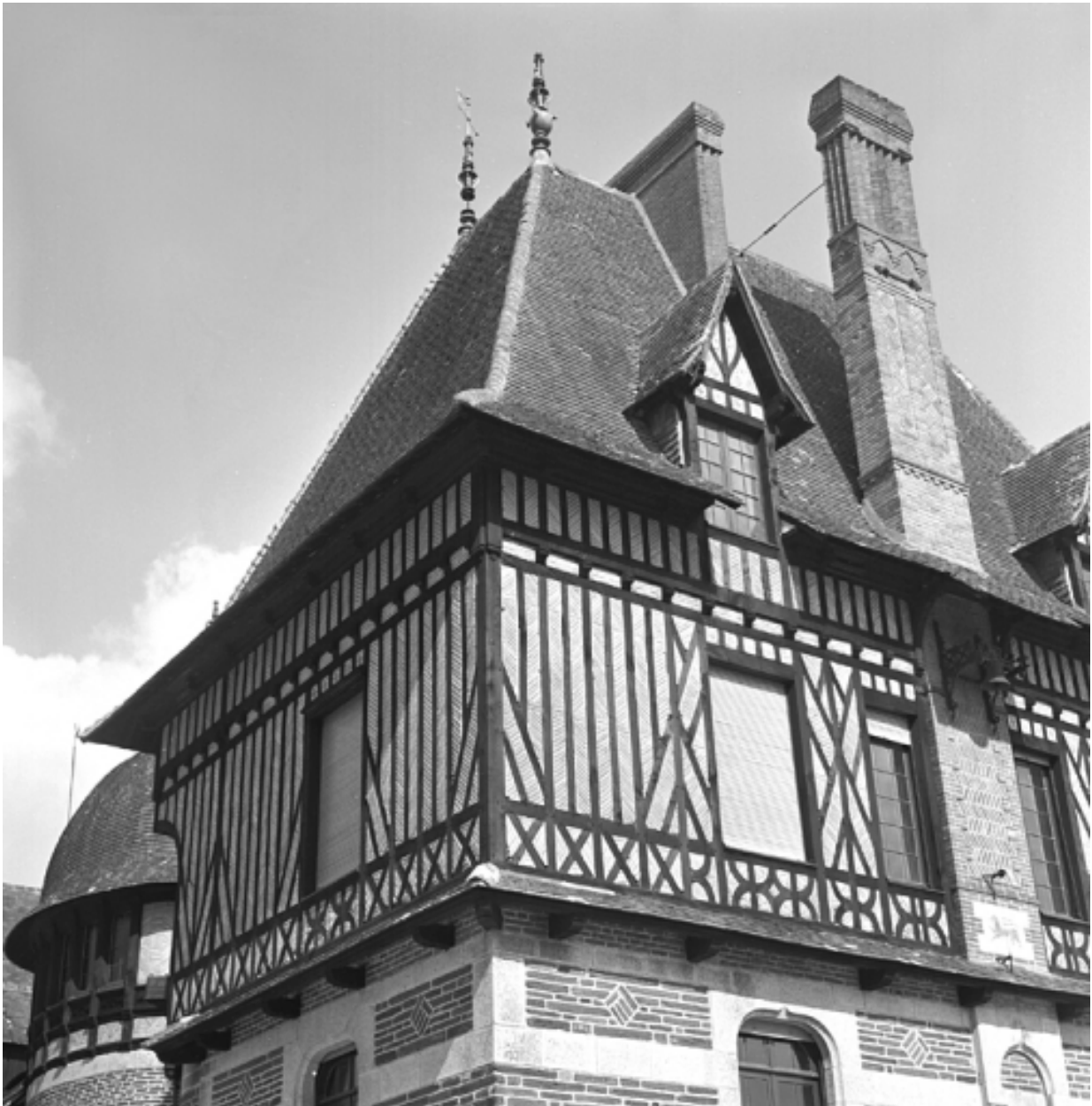
Détail : façade sud
