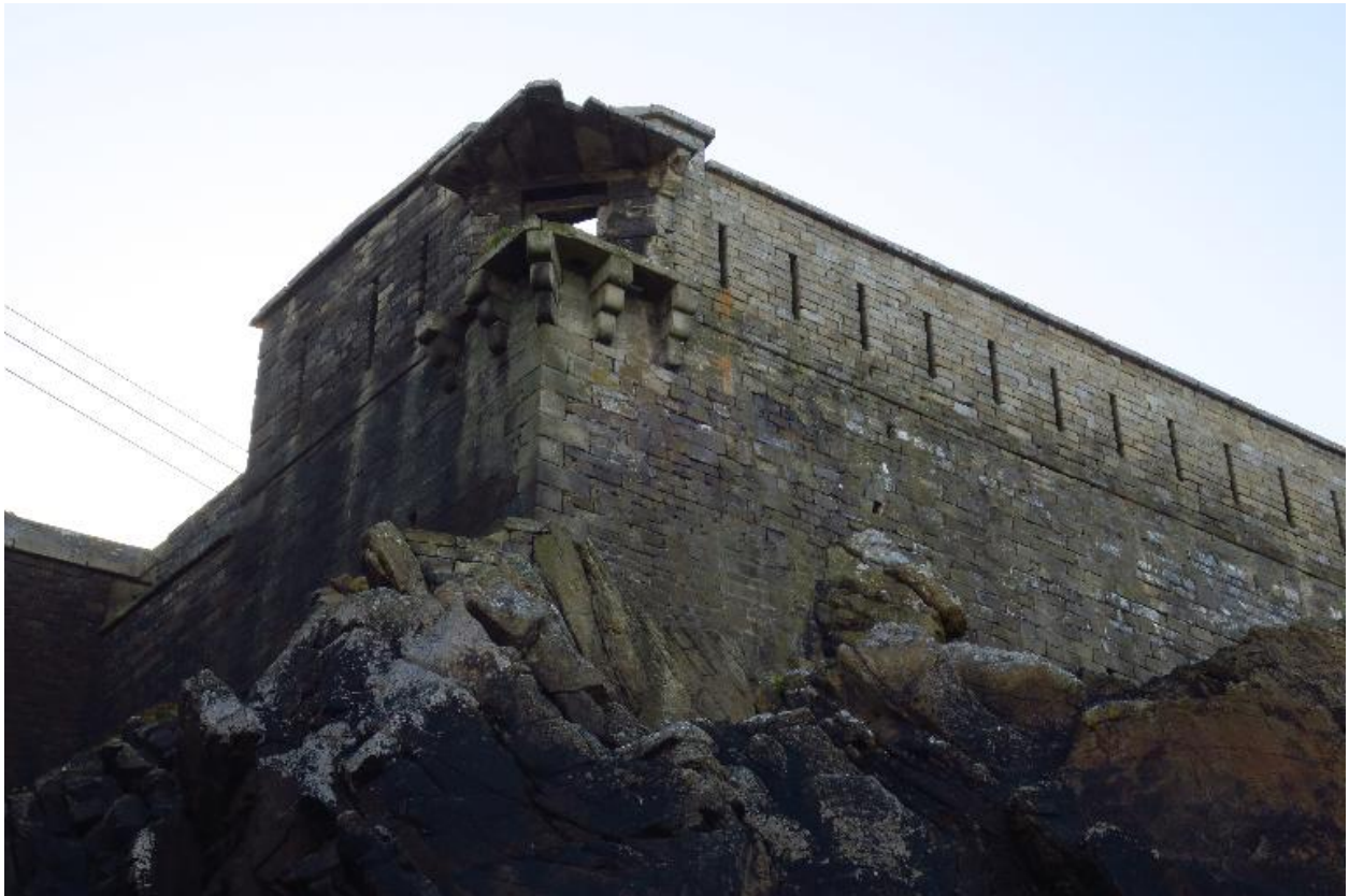
Saint-Pierre-Quiberon, fort de Penthievre, enceinte, bretèche du réduit.
