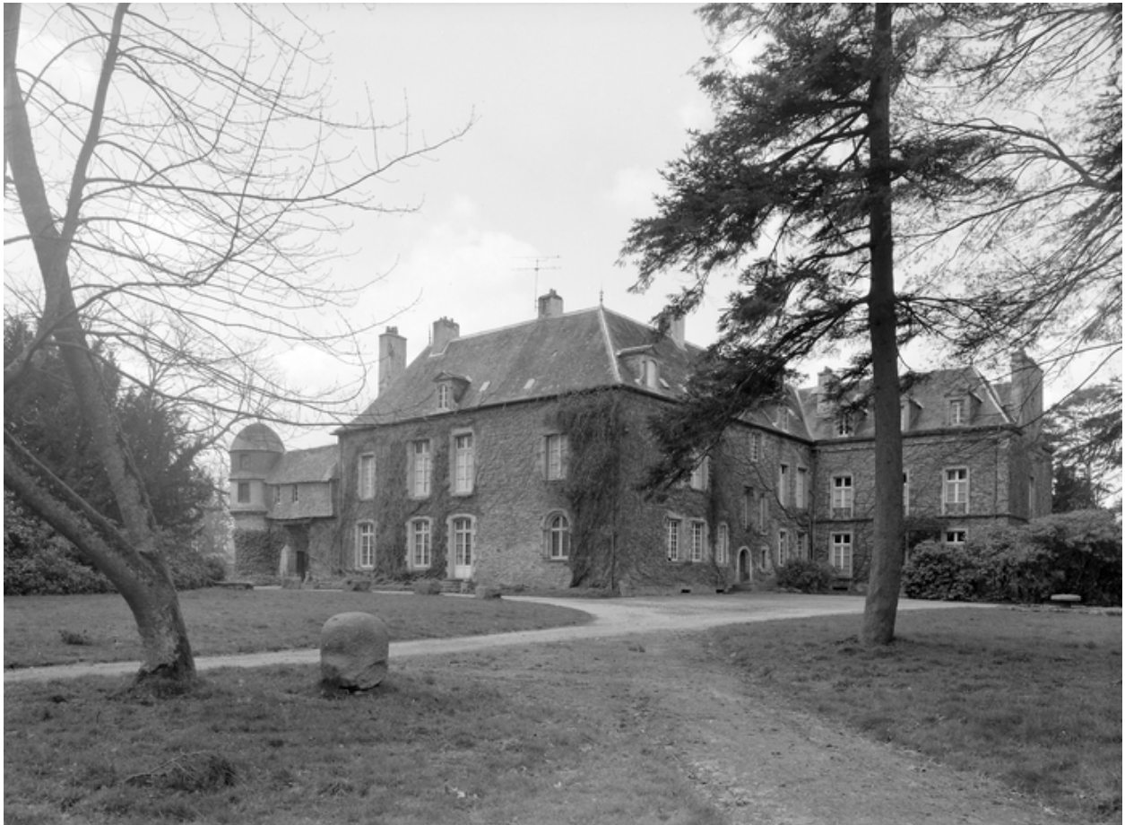
Vue générale façade sur parc
